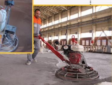
سپس با ماله‌های پروانه‌ای دوار تک یا دوبل به مدت ۶ الی ۱۲ ساعت روی بتن عملیات پرداخت صورت می‌گردد ، که این عمل باعث اختلاط کامل مواد کفپوش با بتن تازه می‌گردد.
